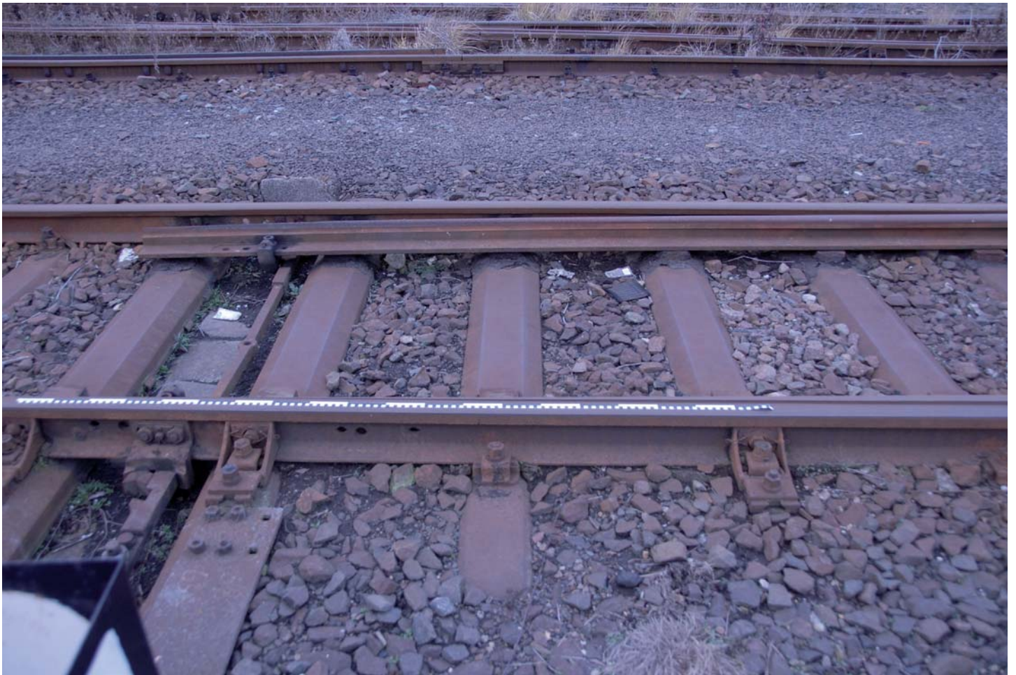
Zungenvorrichtung mit Klammerspitzenverschluß
