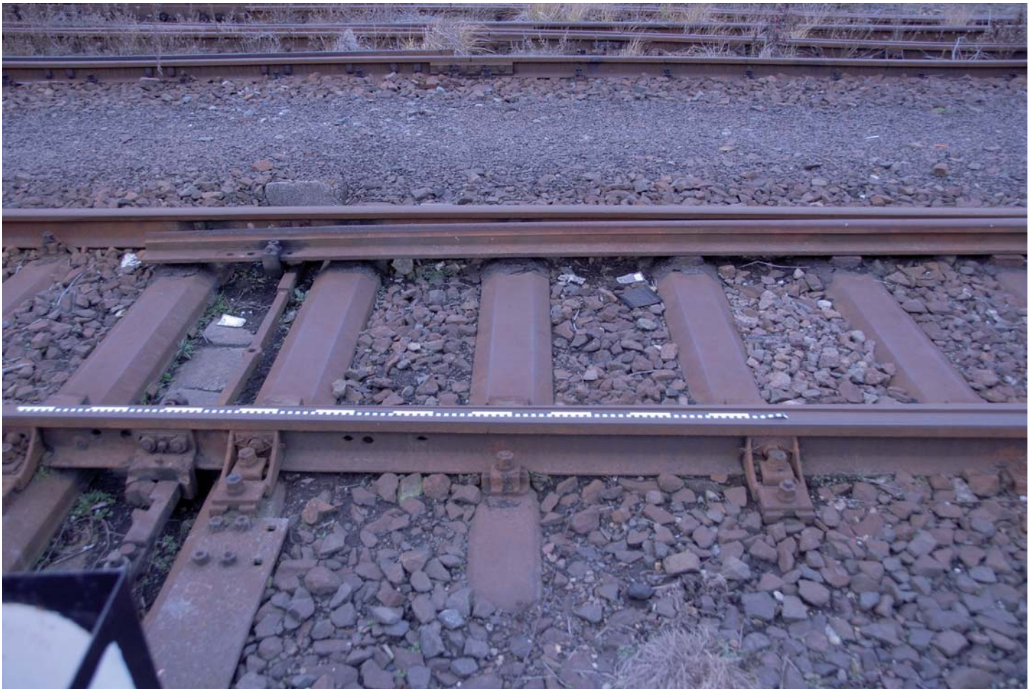
Zungenvorrichtung mit Klammerspitzenverschluß
